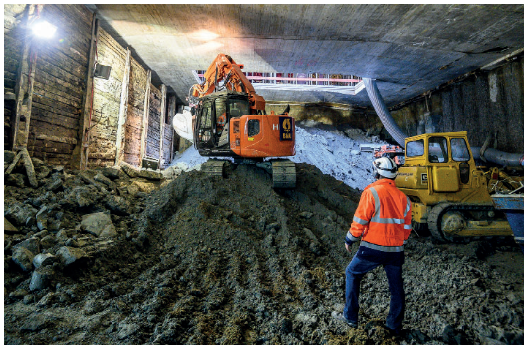
In München wird unterhalb des vielbefahrenen östlichen Altstadttrings eine 140 m lange Tiefgarage errichtet. Bauer Umwelt führt den Aushub der Baugruben aus, zuvor errichtete Bauer Spezialtiefbau eine Bohrpfahlwand.
