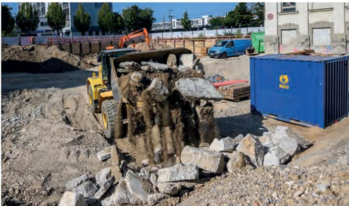
Insgesamt wurden rund 50.000 m<sup>3</sup> Beton abgebrochen sowie gut 125.000 m<sup>3</sup> Boden ausgehoben und entsorgt, darunter ca. 140.000 t Altlasten und 80.000 t gewachsener Boden.
